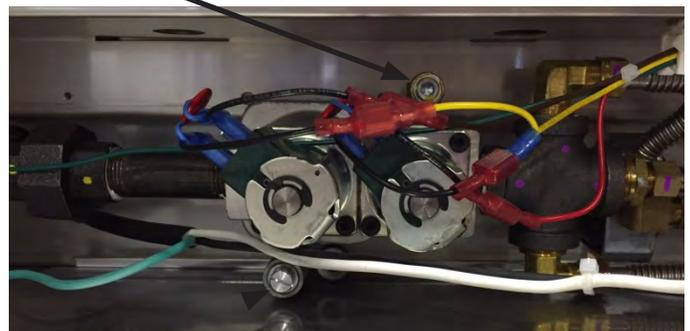
Fig. 3.C - diseño de la válvula después de 2019
